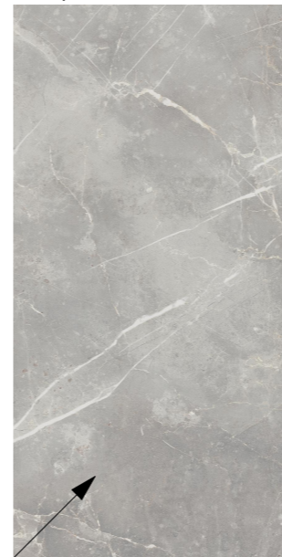
Начало раскладки плитки
